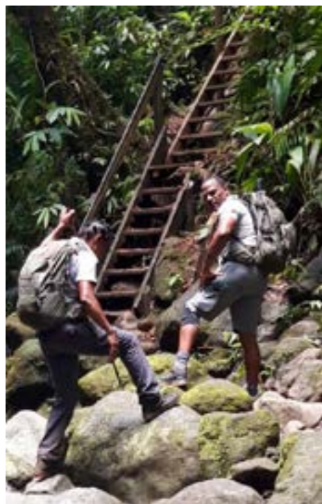
▲ Travaux de réhabilitation du sentier de Grosse Corde Crédit F. BASTARAUD / PNG
