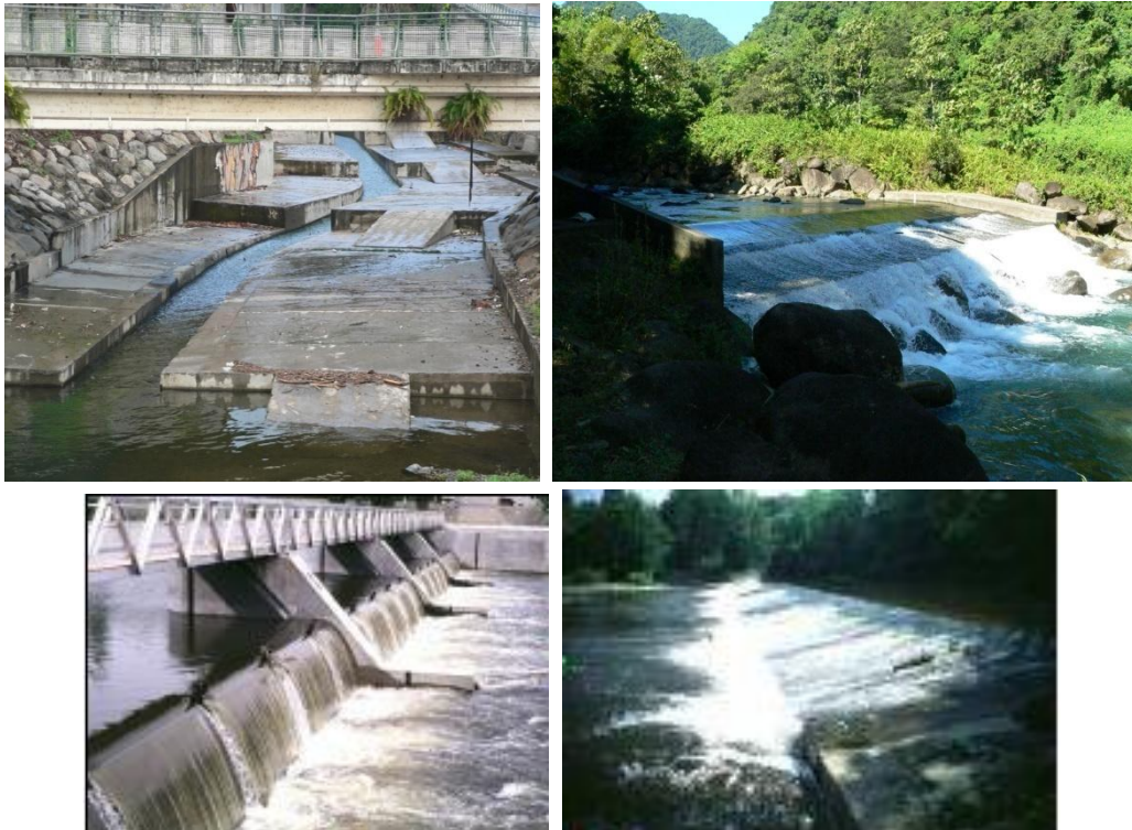
Figure 25 : Exemples d'ouvrages qui peuvent menacer la continuité écologique des cours d'eau de Guadeloupe (source : Mollet et Robert, 2011)
