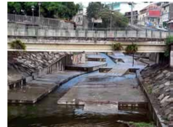
Aménagement du lit en béton, Rivière aux herbes, (Basse-Terre)
