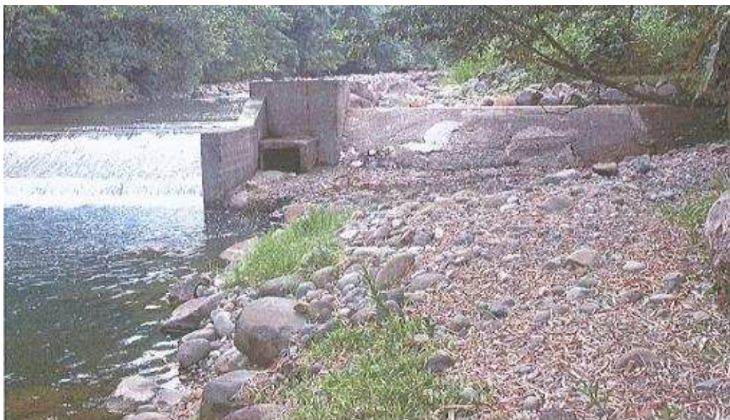
Vue du captage depuis l'aval (Septembre 2004)
