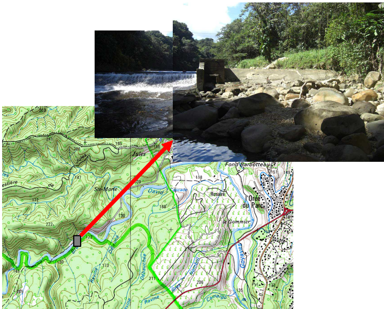
Figure 3 : Seuil de prise d'eau sur la rivière Bras David
