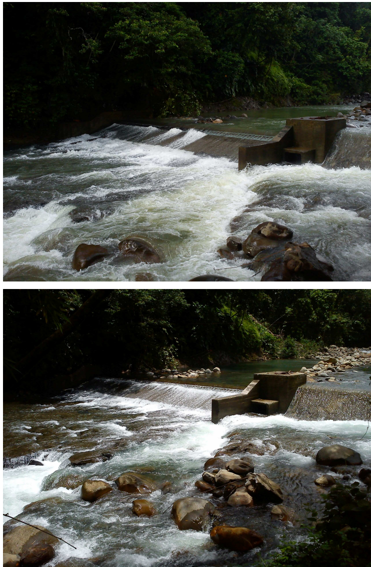
Figure 12 : Evolution de la ligne d'eau en aval de la prise pour des débits de l'ordre de 1,5 m 3 /s et 5-6 m 3 /s
