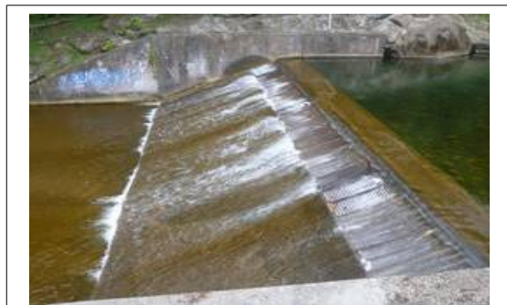
Vue de l'amont - Grille
