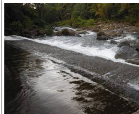
Vue de l'amont
