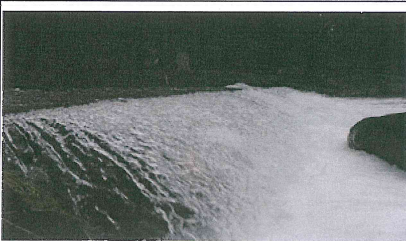
Illustration 2: Vue aval des voies n°3 (à gauche) et 4 (à droite)
