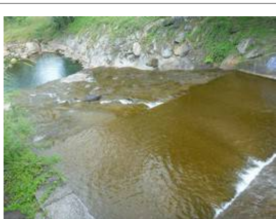
Vue de l'amont
